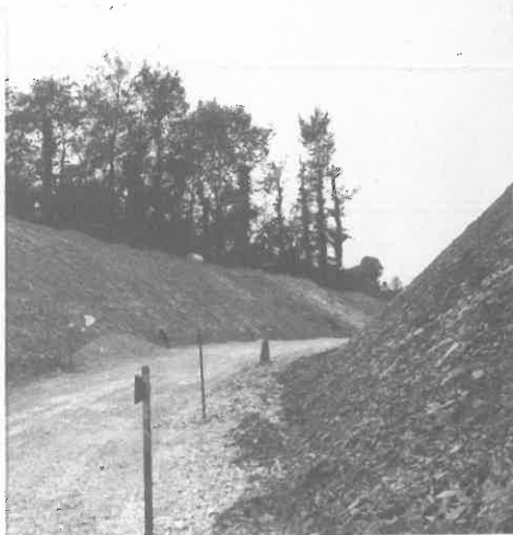
Fig. 34 – Allargamento della strada Novilara-Candelara 1976. Anche questi lavori, spesso indispensabili, sono causa di abbattimento di alberature ed aprono nuove parti di territorio alla edificazione di seconde case. (foto d'archivio)
