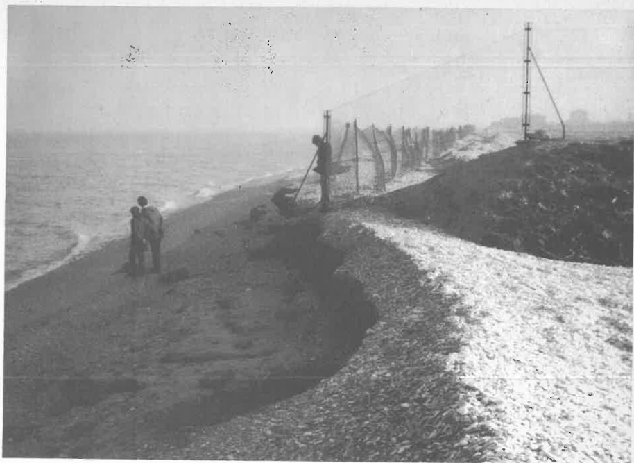
Fig. 3 — Dicembre 1975. Erosione in atto lungo la spiaggia a S.E. della foce del Metauro, denotata dal ben visibile gradino di erosione. Per difendere il camping (di cui è visibile la rete di recinzione) vi è stata sistemata in seguito una scogliera radente,
