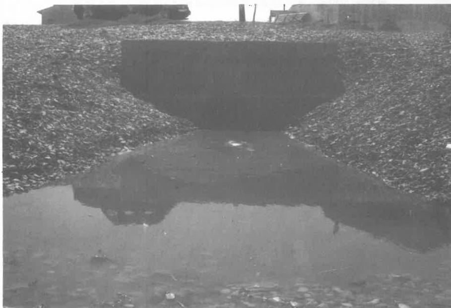
Fig. 2 – Scarico fognario nella Spiaggia di Levante a Fano (Pista Go -Kart). La zona è ancora vietata alla balneazione, ma verrà disinquinata con l'entrata in funzione del depuratore.
